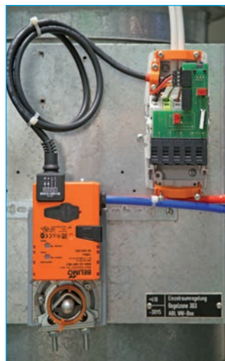
MP-Bus Volumenstromregler mit Field-Power Verkabelungssystem
